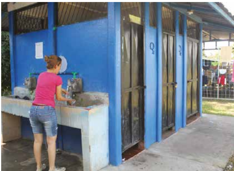
Imagen 2. Infraestructura sanitaria en los alojamientos temporales de Paso Canoas.
