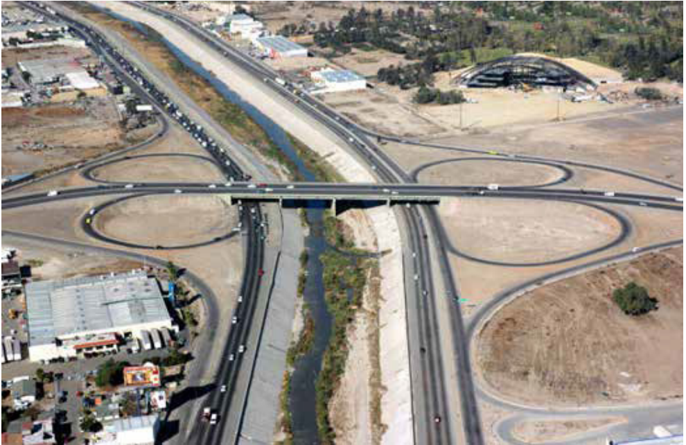
Canalización del río Tijuana
